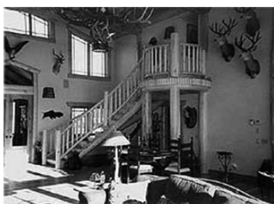
9. att. Kāpnes ar likiem vaigiem un apaļu kāpņu laukumu
