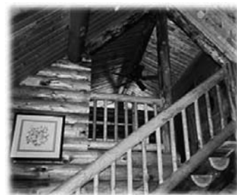
1. att. Piebūvēta kāpņu konstrukcija
