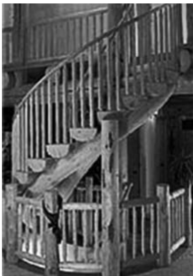
7. att. Kāpnes ar likiem vaigiem un pus-balķa kāpieniem
