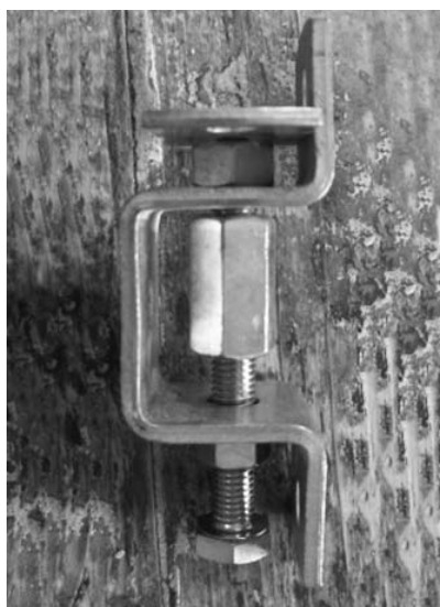
12. att. Metāla detaļu mezgls kāpiena slidināšanai ierobežotā attālumā, ar kontrējošu uzgriezni
