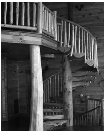
16. att. Brīvi stāvošas pilnībā grieztas — vītņu kāpnes
