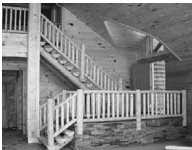
4. att. Uzmontētu balķu kāpnes
