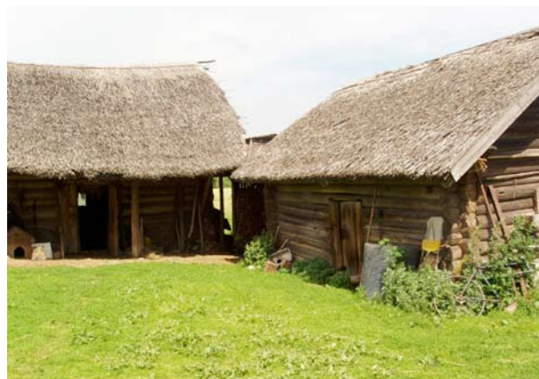
5. attēls. Niedru jumts
