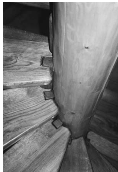
14. att. Kāpņu pakāpieni ap centrālo balstu.
